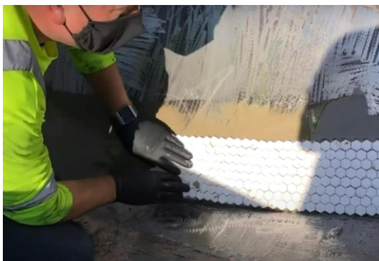
Ремонт желоба в Lapeyre Industria Sands (Калифорния, агрегаты, 2021).
