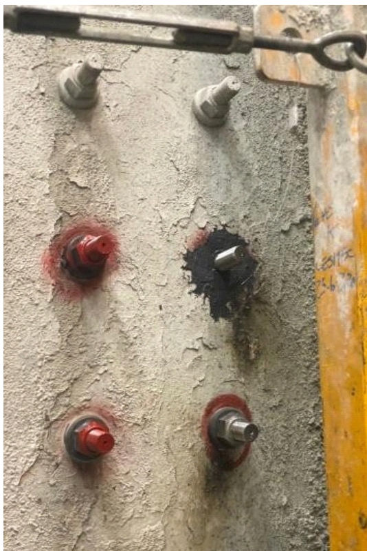
Восстановление перфорированных скважин в Codelco Escondida
